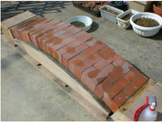
(11) 砂の間詰め完了
