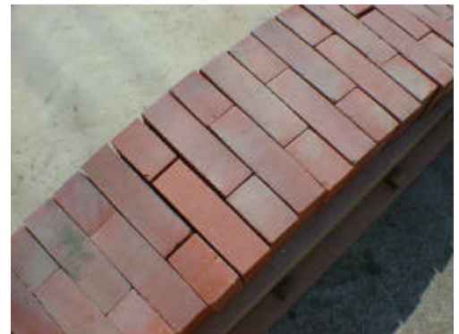
煉瓦の間（上側）に隙間がある
