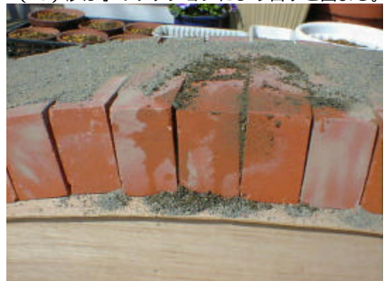
(10) 砂は水のサクシオンにより自ずと固まる。
