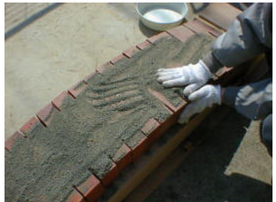
(10) 砂は水のサクシオンにより自ずと固まる。
